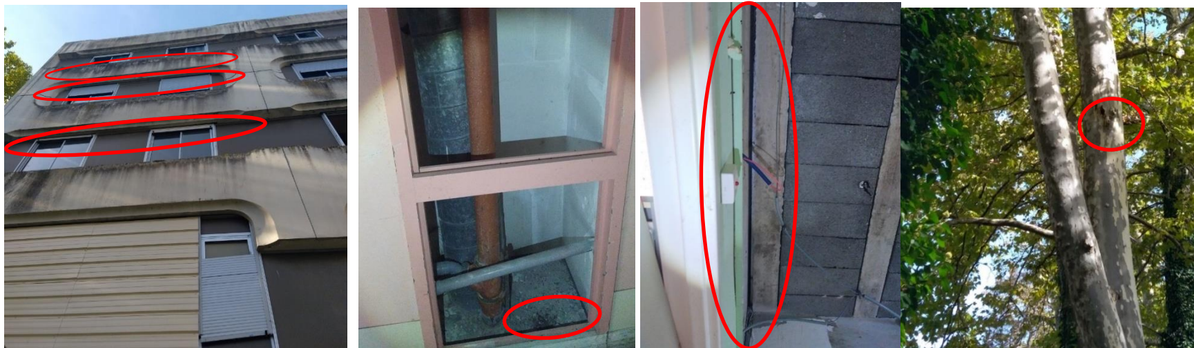
Figure 3 : de gauche à droite : façade de l'hôpital favorable aux espèces des milieux bâti, guano dans les recoins, joint entre les parpaings accueillant des pipistrelles et platane à cavité
