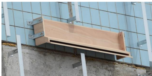
Début du chantier
