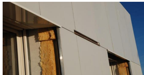
Fin du chantier
